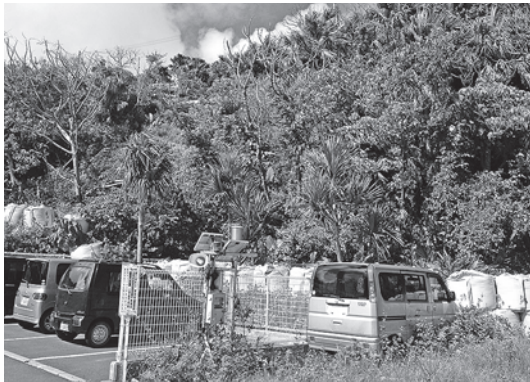
大型土のう、警報システム
