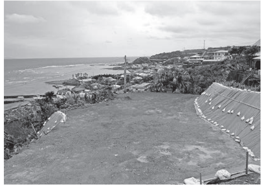
頭部排土工が完成
