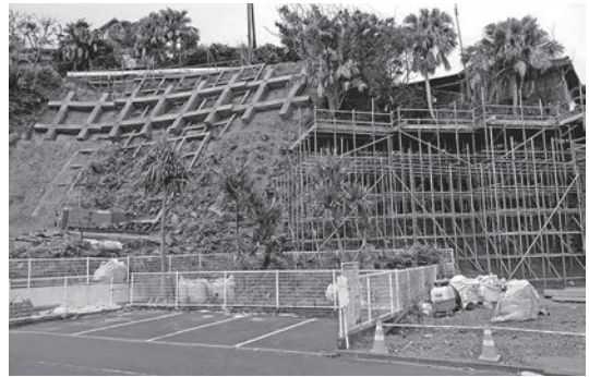
アンカー工の施工状況
