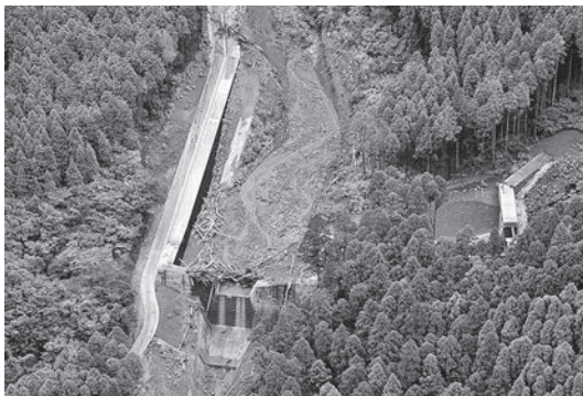
写真-3 土石流を捕捉した2号堰堤
