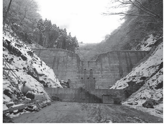
写真-6 災害関連緊急砂防事業の工事施工状況
