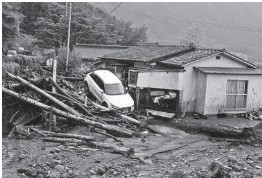
写真-2 半壊した人家
