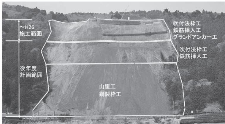
写真-6 斜面正面と対策工区分 (H26.4.17撮影)
