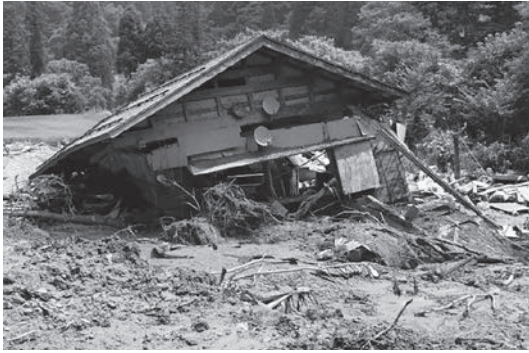
土砂に押し流された民家（栃尾地域・森上）
