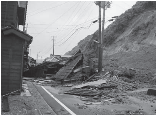
土砂に潰された民家（寺泊地域・寺泊山田）
