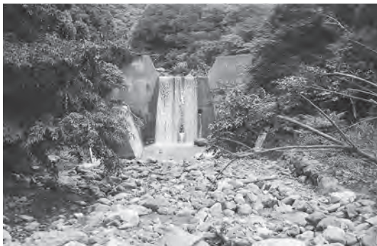
既設堰堤：H=9.5m，L=44.0m
