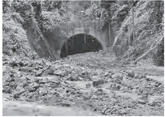
国道315号金山谷トンネル付近
