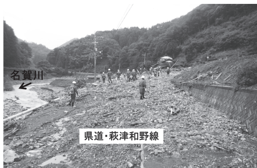
名賀川はん濫及び県道への土砂流出状況 （津和野町名賀地内）
