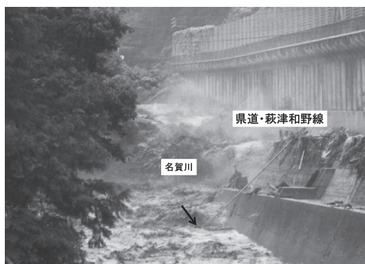
名賀川はん濫状況（津和野町高峯地内）
