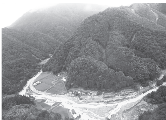
上空からの災害状況（津和野町名賀地内）
