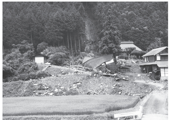
地すべり災害状況（津和野町名賀地内）
