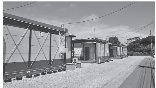
応急仮設住宅
