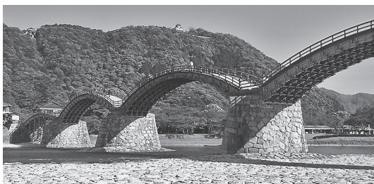
錦帯橋と岩国城（写真奥）
