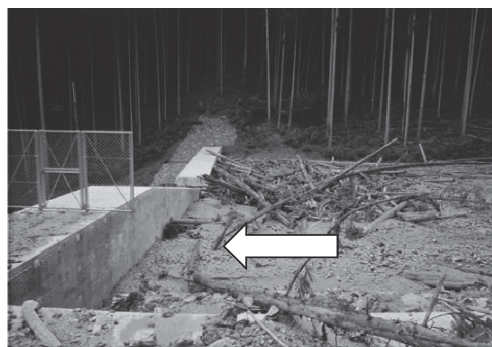
写真3 砂防えん堤が土砂・流木を抑止
