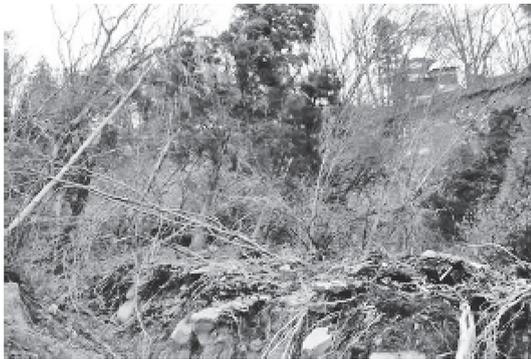
Bブロックの現地踏査：地すべり本体表層の倒木方向が一定で、土塊は回転運動をしつつマスとして挙動したと推定される
