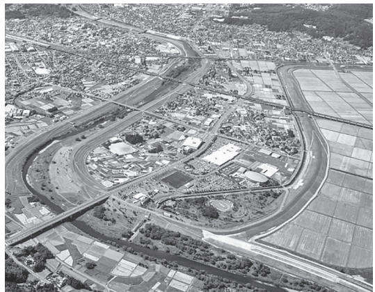
一関遊水地周囲堤完成後（平成24年）
