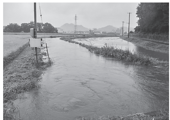
写真-1 福岡深谷地内の河川増水による越流
