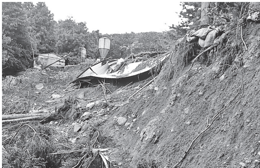
写真－３ 越河平地区の地すべり
