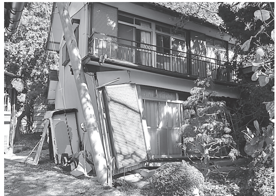
写真－４ 越河平地区の地すべりによる全壊家屋
