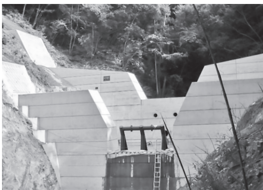
写真-5 完成した砂防堰堤
