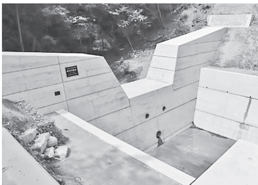
写真-4 完成した砂防堰堤
