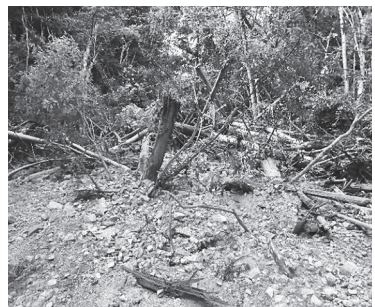
写真-3 土砂・流木の堆積状況
