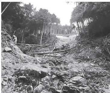
写真-1 崩壊状況
