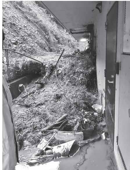
有福（55）地区被災状況
