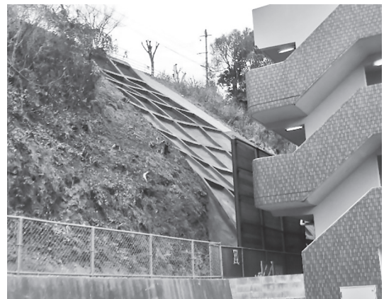
有福（55）地区施工状況
