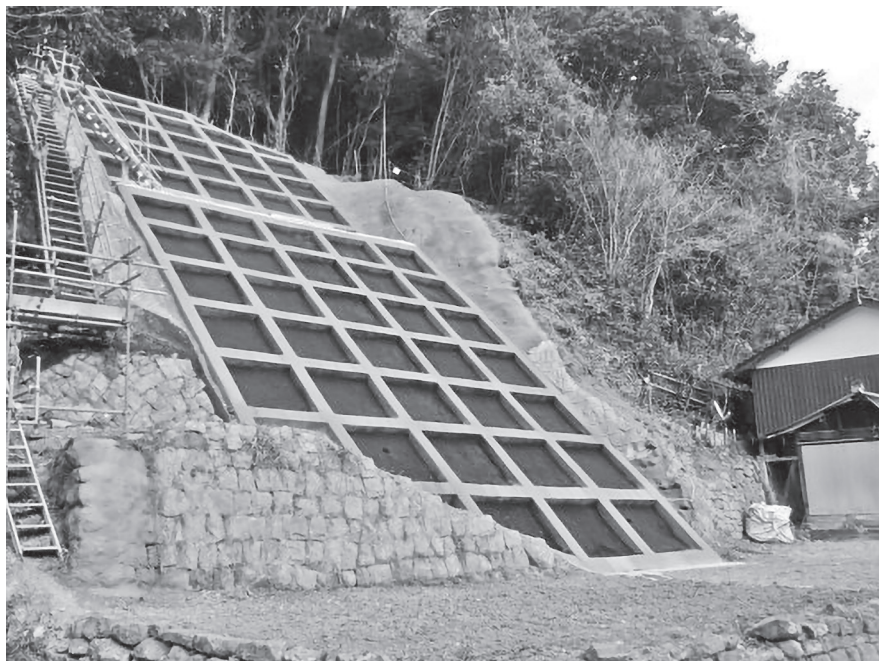
杉谷地区施工状況
