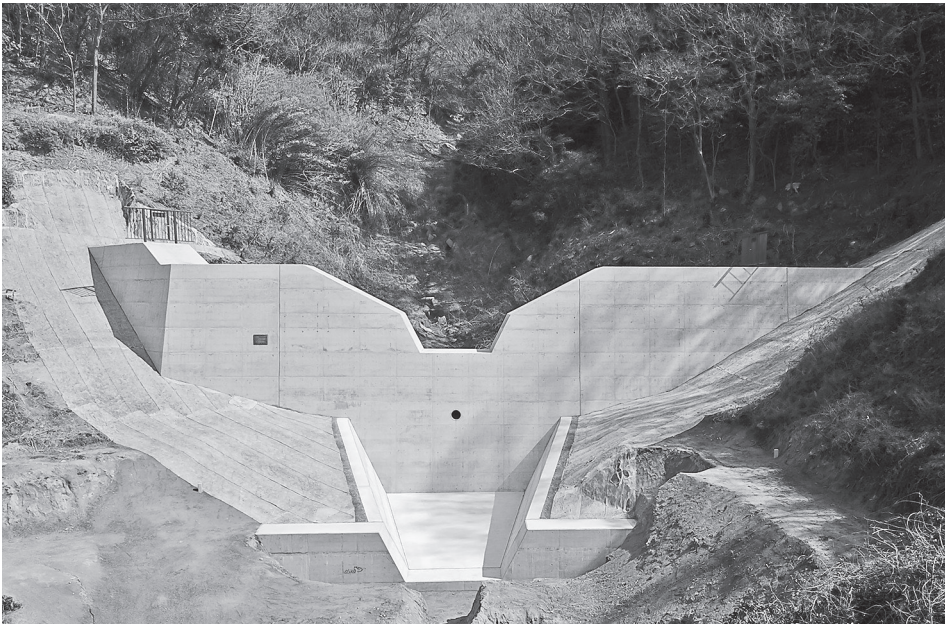
堰堤完成状況（H30.3.3撮影）
