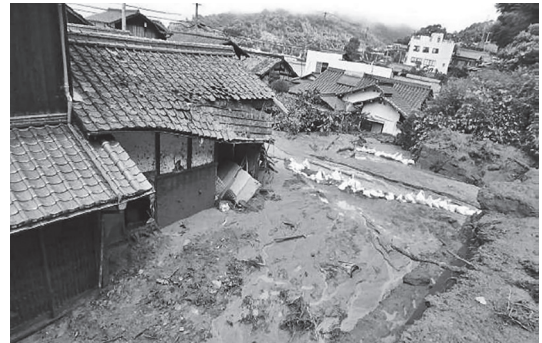
被災状況（H28.6.23撮影）
