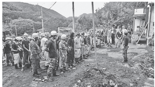
ボランティア等による土砂撤去作業開始前状況
