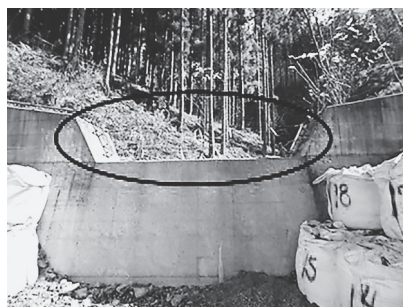
②ワイヤーセンサーの設置
