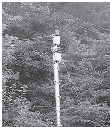
①サイレンの設置
