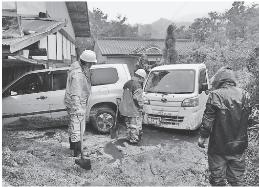
土砂撤去作業状況写真
