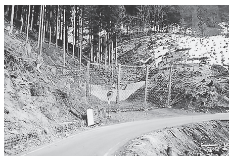
④鋼製防護柵（強靱ワイヤーネット）の設置
