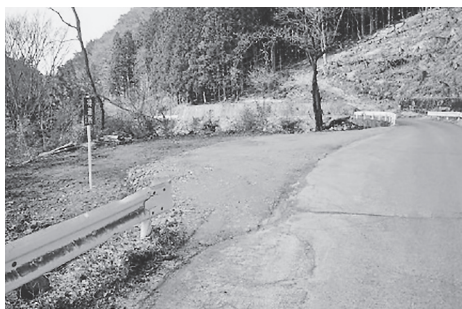
⑤狭小道路に対する工事車両等の待避所設置
