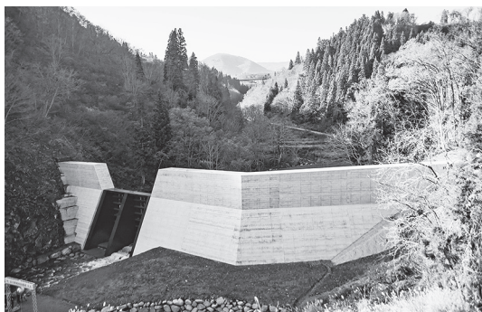
写真－1 出川照岡砂防堰堤（地図⑤） 透過型堰堤（高さ13m，幅91.5m）
