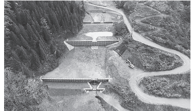
山腹工（土留工）
