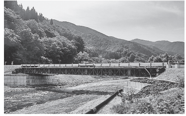
国土交通省 応急組立橋
