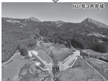
写真－４ 災害関連緊急砂防事業 山王谷川２地区の砂防堰堤設置の状況
