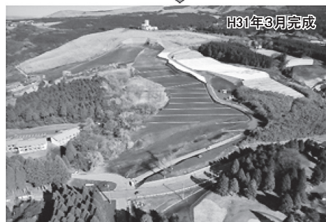
写真－５ 災害関連緊急地すべり対策事業 高野台地区の地すべり抑止杭設置等の状況
