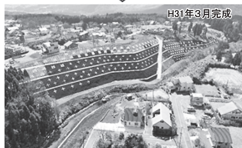
写真－７ 災害関連緊急急傾斜地崩壊対策事業 下鳥小塚地区のグランドアンカー設置等の状況
