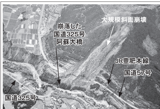
写真-1 立野地区の大規模斜面崩壊で寸断された国道・JR 豊肥本線
