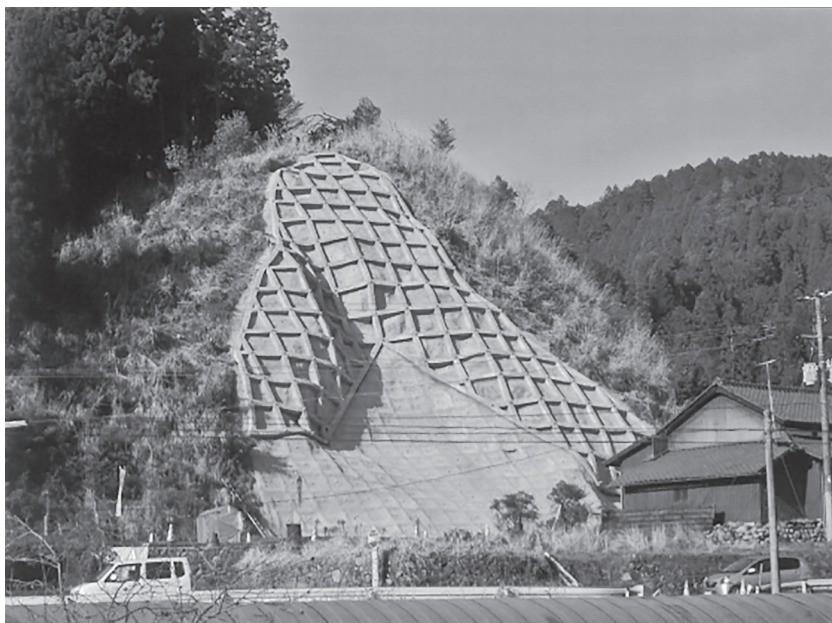
写真-6 災害関連地域防災がけ崩れ対策事業での法面対策実施箇所
