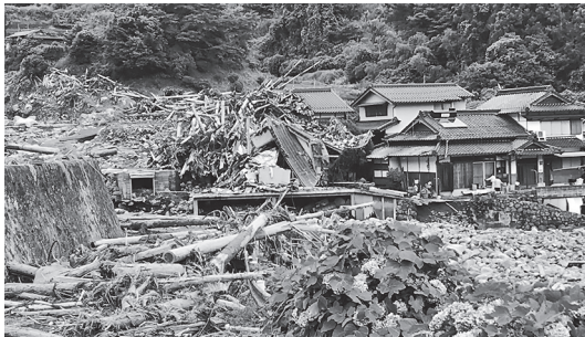
写真－2 住居に流れ込んだ大量の土砂・流木 (屋椎地区)
