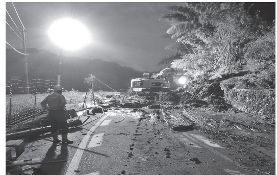
写真－4 昼夜を徹して行われた道路啓開(国道211号)
