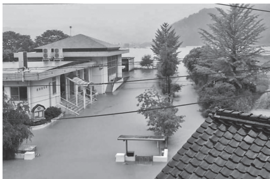
写真-5 輪中提施工箇所における内水被害：由良川流域では安全となりましたが、予想を超える内水被害が発生していることから、その対策として排水ポンプ整備や宅地嵩上げ助成が有効だと考えています（写真-5）。
