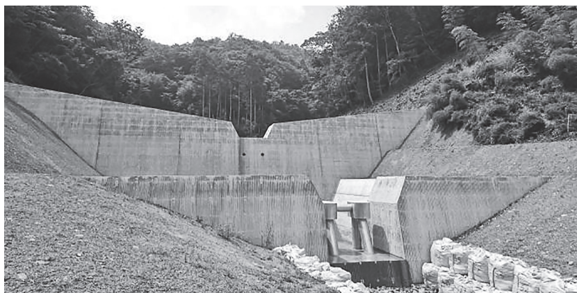
写真-4 京都府に緊急対応していただいた砂防施設
