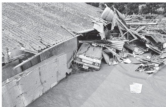
写真－６ 客地区の被災状況
