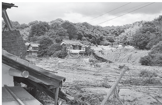
写真－４ 庄地区の被災状況
