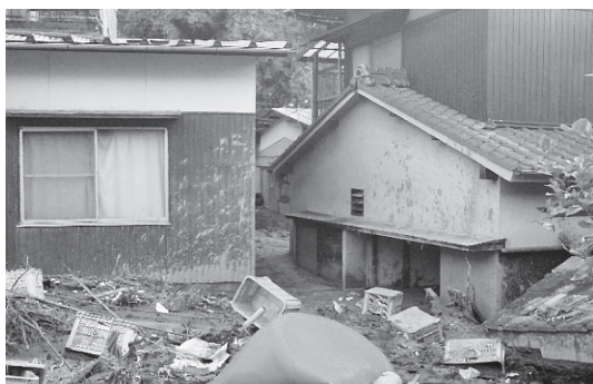
写真－５ 高浜地区の被災状況
