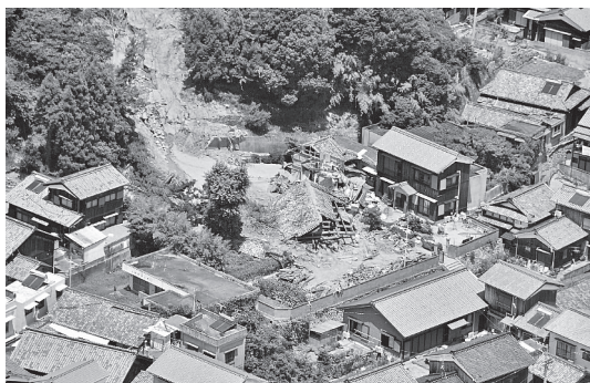
写真－３ 上怒和地区の被災状況
