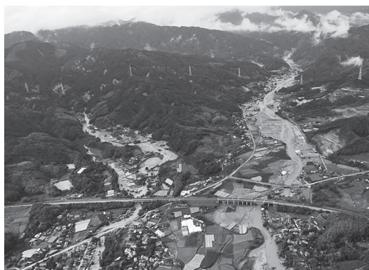
写真－1 赤谷川流域（右）と白木谷川流域の被災状況
