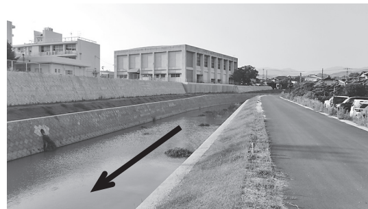
写真－4 完成した桂川護岸（福岡県より提供）
