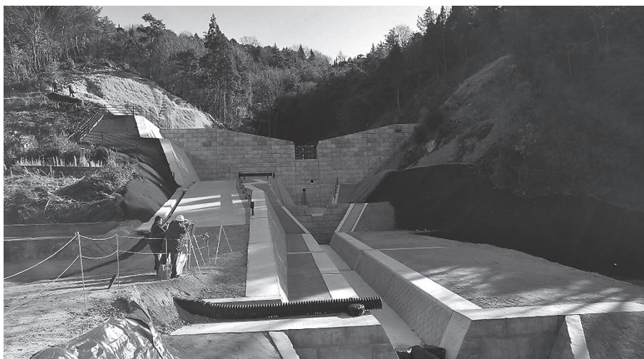
写真-9 国直轄砂防事業 背戸の川砂防施設（天応地区）
