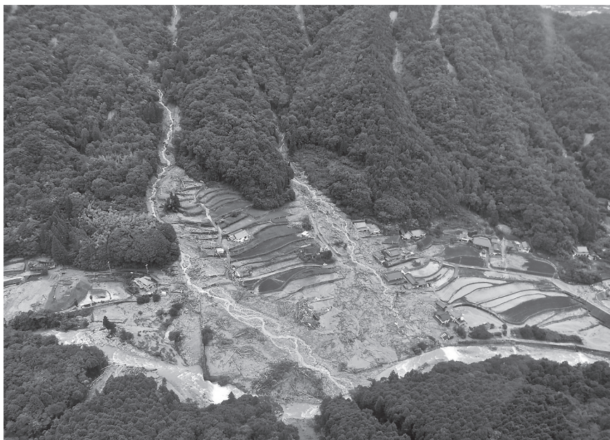
写真-7 土石流の発生により大量の土砂や流木に飲み込まれた家屋や農地（安浦地区）
