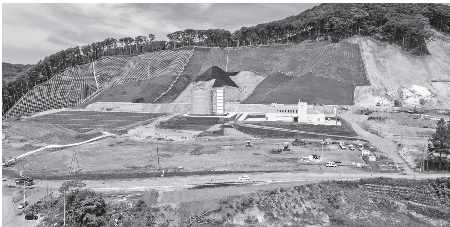
図－5 富里地区の復旧の様子
