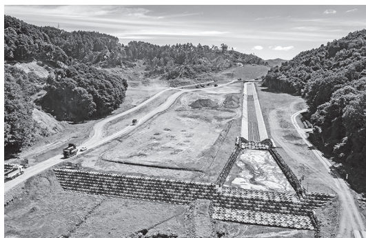
図－4 厚真川水系直轄砂防事業日高幌内川基幹砂防築堤
