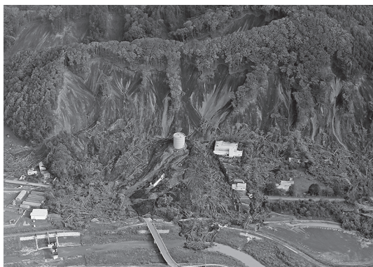
図－3 大規模な土砂災害が発生した富里浄水場（北海道提供）
