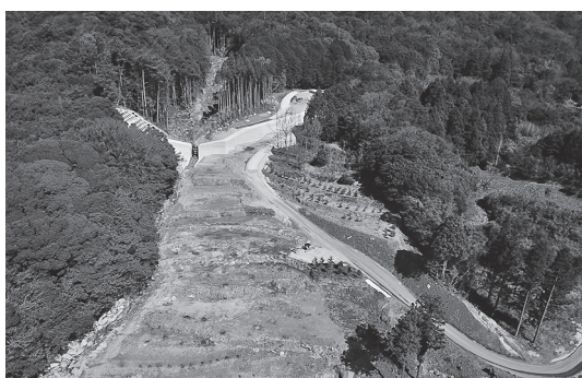
写真－9 砂防堰堤完成状況
