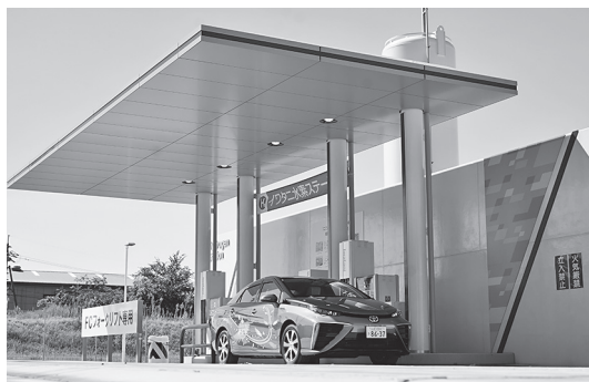
写真－2 水素ステーション
