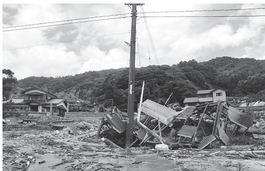
写真-4 樋口地区の土砂災害
