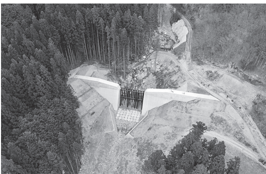
写真-6 完成した砂防堰堤
