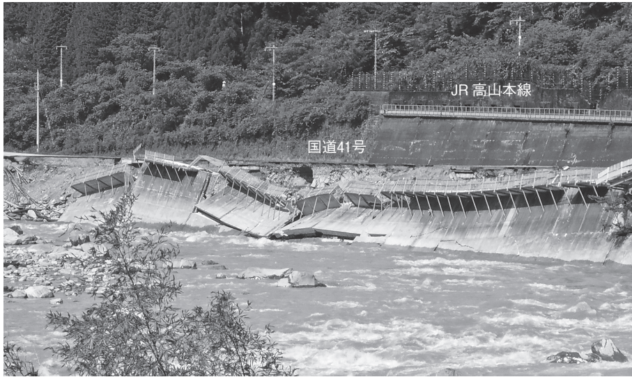
写真－2 約500mにわたり崩壊した国道41号（小坂町門坂地内）手前は飛騨川
