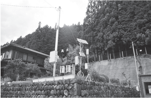
写真-5 土石流センサーと連動したサイレンの設置
