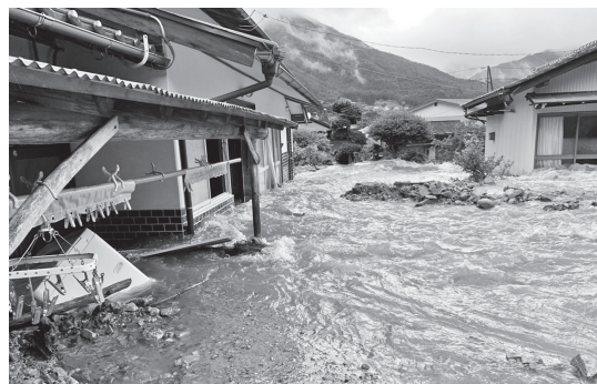
写真－3 土砂災害による被災状況
