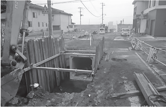
写真-9 住宅地から防災緑地公園内までの暗渠水路区間は既往最大雨量に対応した規格のボックスカルバートに改修
