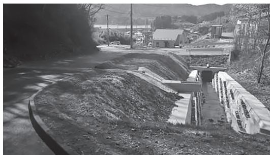
写真－8 上流側の護岸は強固なブロック積みに改修
