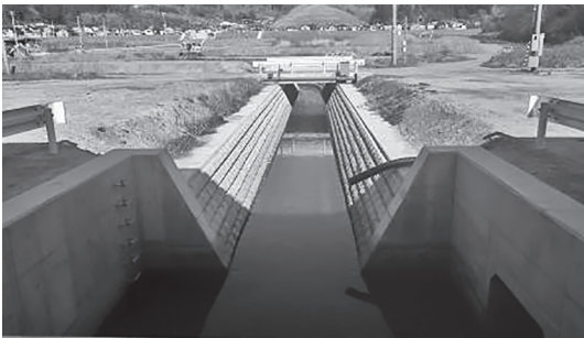
写真-10 防災緑地公園から防潮堤水門までの区間は、土砂流入時の対策を考慮し、開渠水路として改修
