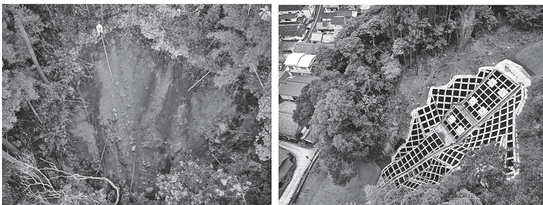
写真－6 外浦地区：着手前（左）と完成後（右）
