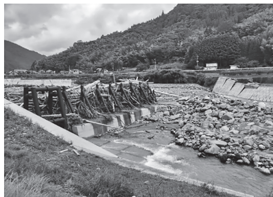
写真-10 令和5年7月豪雨での流木捕捉状況
