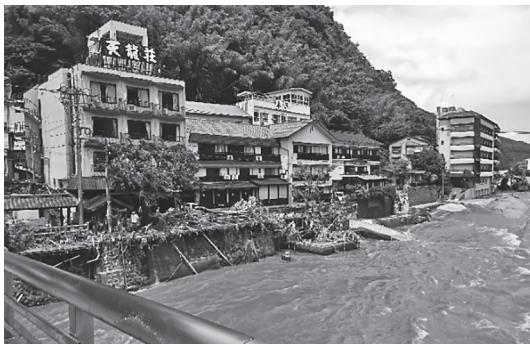
写真－４ 天ヶ瀬温泉街浸水被害
