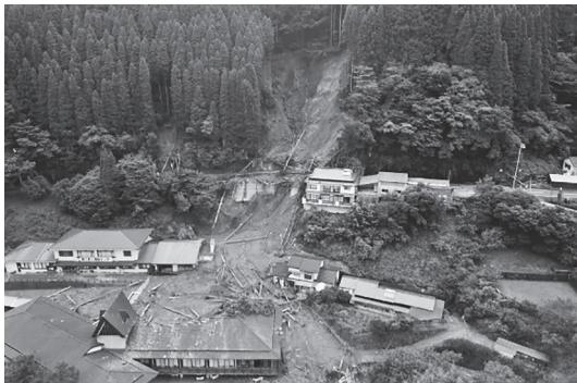
写真－６ 津江老人福祉センター
