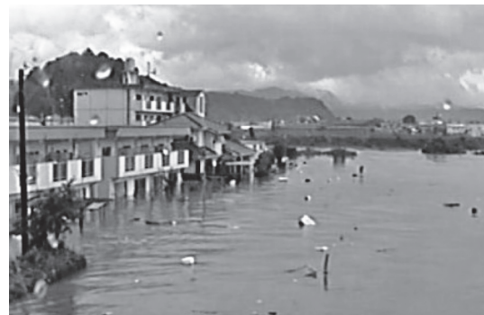
写真－５ 北友田３丁目住宅浸水状況
