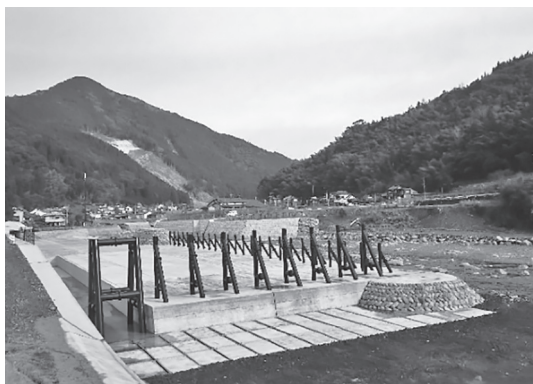
写真-9 流木捕捉工
