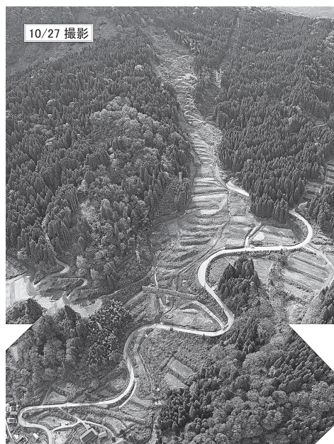
写真－4 復旧工事（出典：新潟県）
