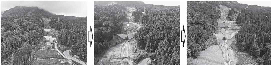
写真－5 地すべり復旧工事（出典：猪又建設（株））
