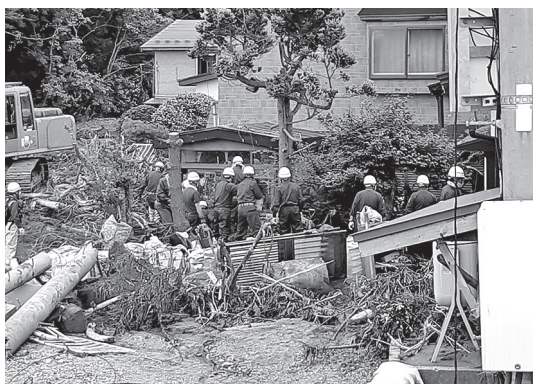
写真－11 住居内からの土砂運搬
