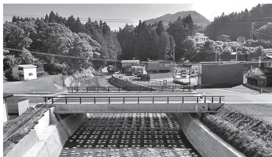
写真－12 小赤川橋完成
