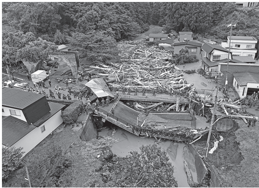
写真-4 小赤川橋崩落
