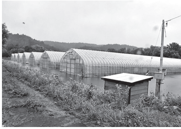
写真-1 ハウス冠水
