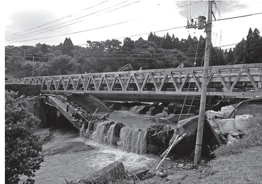
写真－8 仮橋（しもきた国土交通三日橋）
