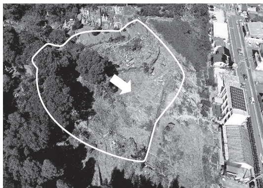
写真-3 被災状況（全景）
