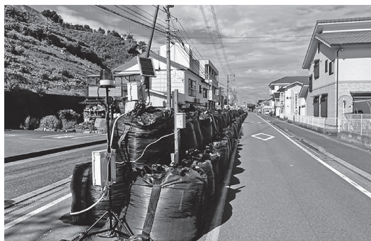
写真-7 市道への大型土のう設置状況
