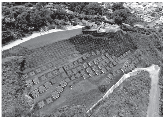
写真-8 復旧工事の状況
