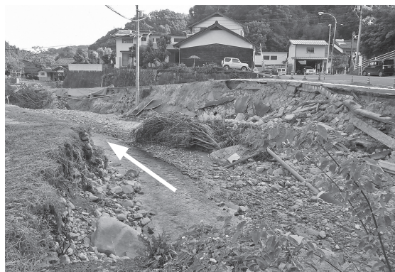
写真－2 萱野川が氾濫し家屋が倒壊（左）、飯石川では河川護岸や道路が崩壊した（右）
