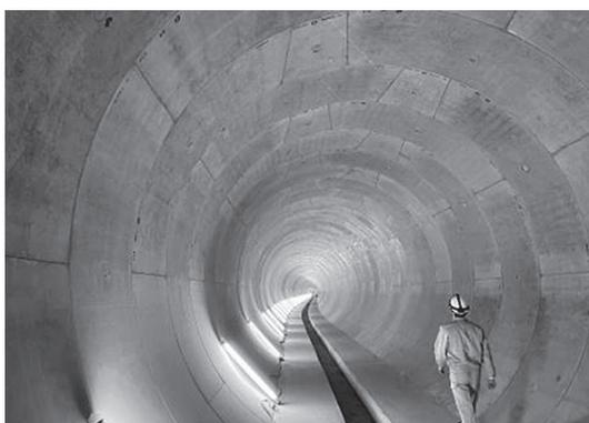
写真-9 雨水貯留管内部の状況
