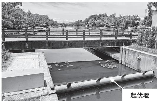
写真-7 佐賀城お濠の堰設置による貯留機能の確保
