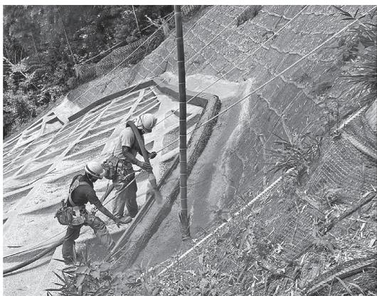
写真-6 急傾斜地崩壊防止事業施工状況
