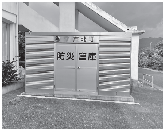
写真-5 防災倉庫（地域活性化センター）
