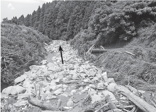
写真－8 下流へ流出した岩石
