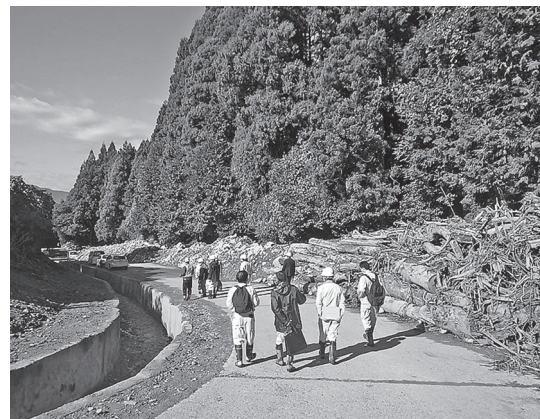
写真－9 関係機関による現地確認（被災3カ月後）
