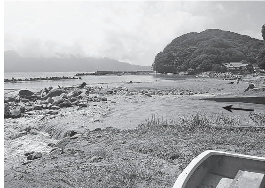
写真-3 杉津海岸の被災状況
