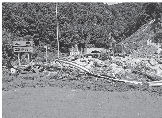
写真－６ 高速道路を覆いつくした土砂
