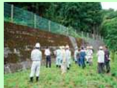
土砂災害危険箇所の点検
