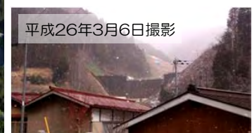
1号砂防堰堤（本体完成）
