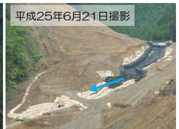
排水路工（完成）
