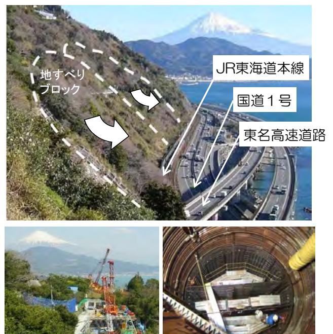
深礎杭工施工状況
