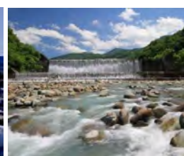
六瀧砂防堰堤 （山形県庄内町）
