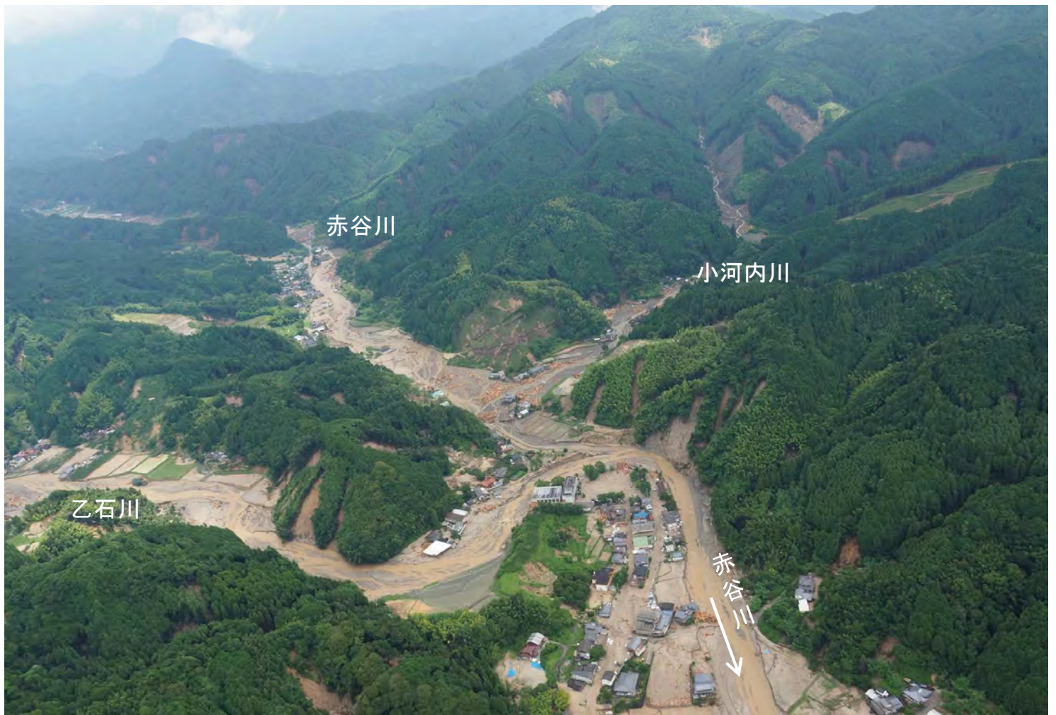
平成29年7月九州北部豪雨 赤谷川、小河内川、乙石川合流点付近の土砂・流木による被害 (福岡県朝倉市)
