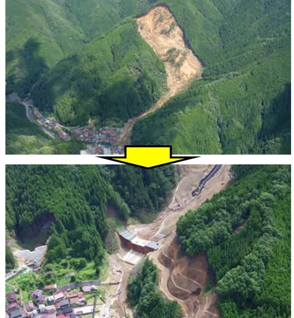
平成23年紀伊半島大水害対策状況（奈良県野迫川村）
