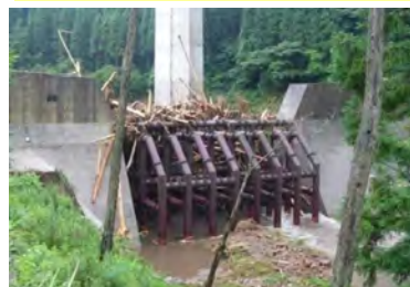
透過型砂防堰堤(熊本県小国町)
