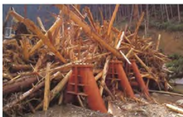
流木捕捉工(大分県中津市)
