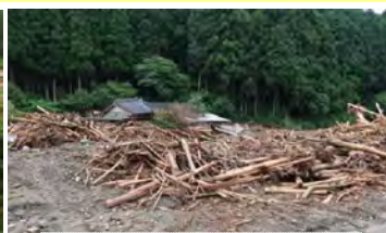
流木による家屋被害(奈良ヶ谷川)
