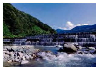
瀬場砂防堰堤 （山形県庄内町）
