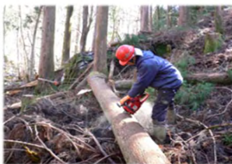
支障木の撤去（高知県土佐町）
