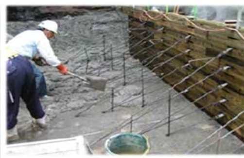
地場産間伐材の積極的利用（高知県土佐町）
