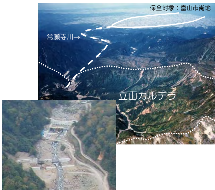
砂防堰堤の整備状況
