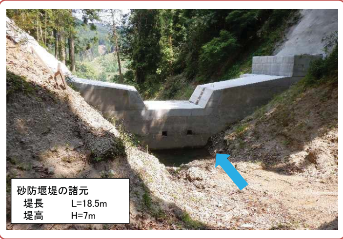
土砂捕捉前 (R2. 5. 28撮影)
