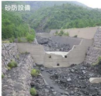
砂防堰堤の天端摩耗により機能低下
