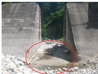
流水の集中による摩耗・損傷
