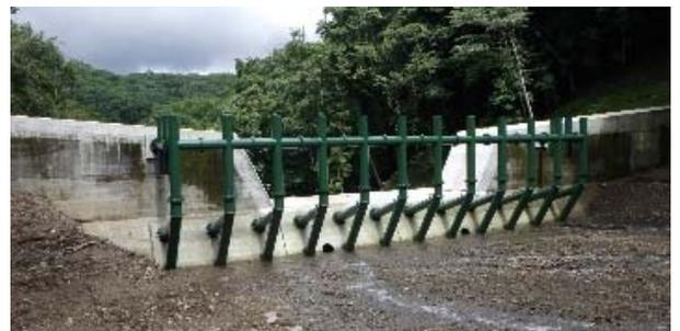
既設砂防堰堤に流木捕捉工を追加設置することで、堰堤を多機能化
