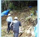
がけ崩れ箇所調査
