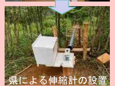
県による伸縮計の設置
