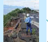
地すべり箇所調査
