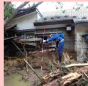
流木堆積状況の調査
