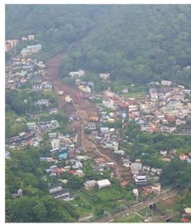
静岡県熱海市における災害発生状況
