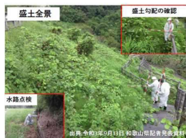
盛土総点検実施状況
