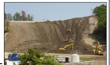
盛土の撤去工事のイメージ
