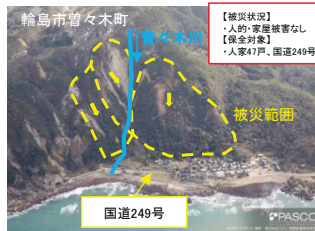
■ 国道249号沿岸部で発生した大規模な地すべり災害(直轄地すべり対策災害関連緊急事業実施箇所)
