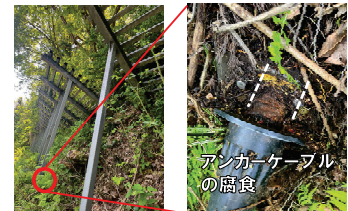
■雪崩予防柵のアンカーの損傷
