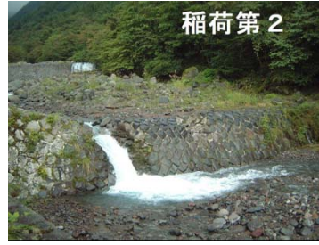
登録有形文化財・稲荷第2砂防堰堤（大正9年建設）
