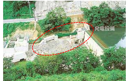
岡山県美作市 梶並川砂防えん堤
