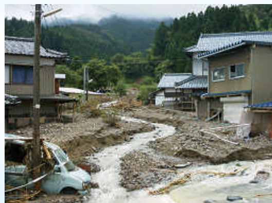
福井豪雨における土砂災害被害（福井県美山町）
